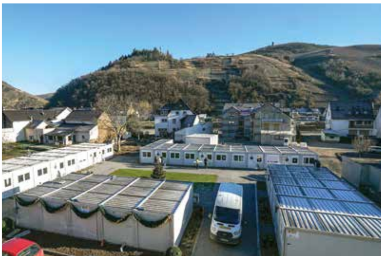
Oben: Die neu errichtete Gemeinschaftswohnanlage in Dernau hat elf Wohneinheiten sowie einen Begegnungsraum.
